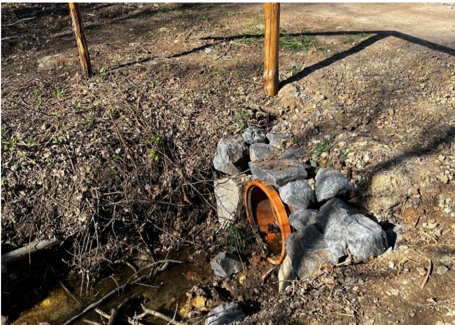
Bild 11: Einbau von Abflussleitungen (Detail)
